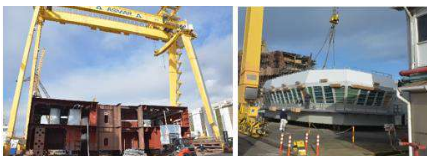
Montaje de Bloques Proyecto RH con Outfitting
